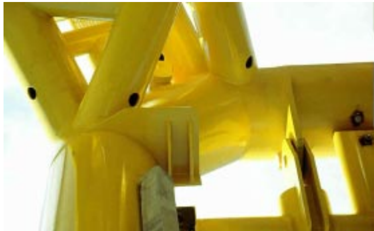
Rautaruukki Steelin Presteel Oy:n valmistamia järeitä putkia öljynporauslautan merenalaisissa suojarakenteissa.
