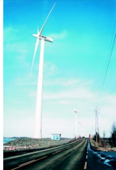
Hyötytuuli Oy:n Meri-Porin tuulipuisto, pintakäsittelytyöt.
