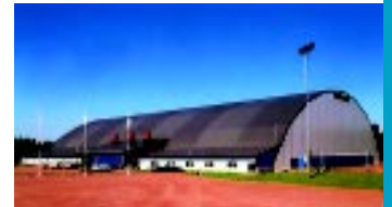
Allhall, täysimittainen jalkapallohalli Ahvenanmaalla.
