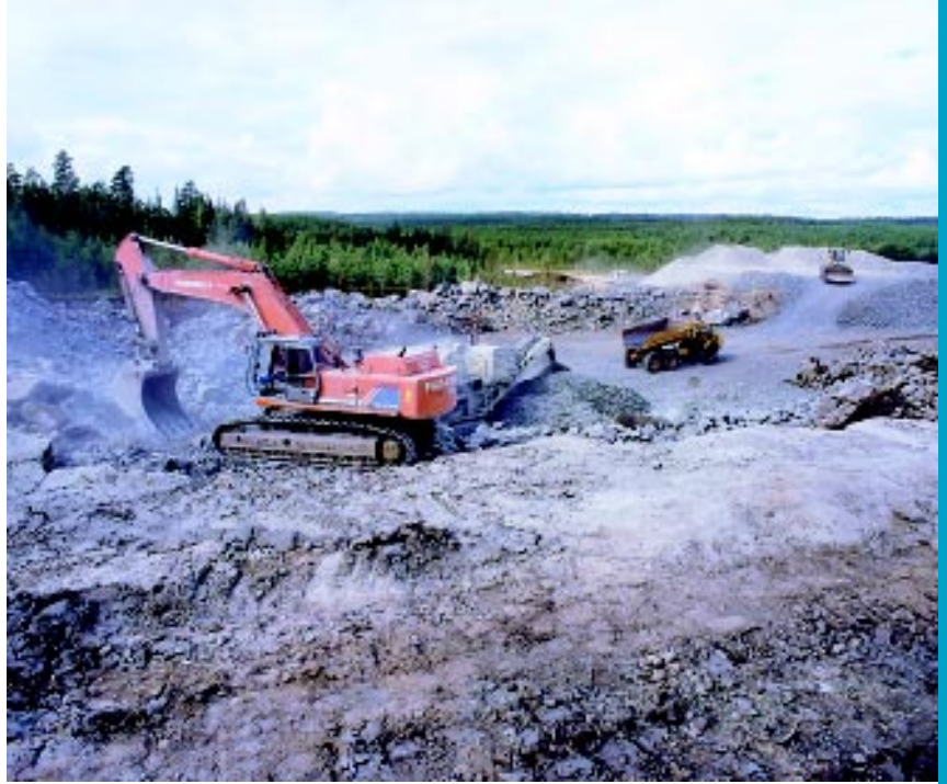
Maakaasun runkoputki välillä Lappeenranta - Luumäki.
