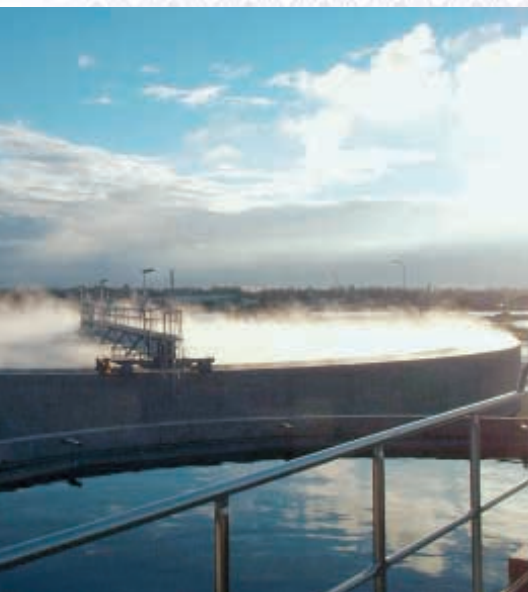
Skanska Econet Oy:n urakoima Stora Enson Skutskärin sellutehtaan biologinen puhdistamo, johon Etteplan on suunnitellut sähköistyksen ja kenttäinstrumentoinnin.
