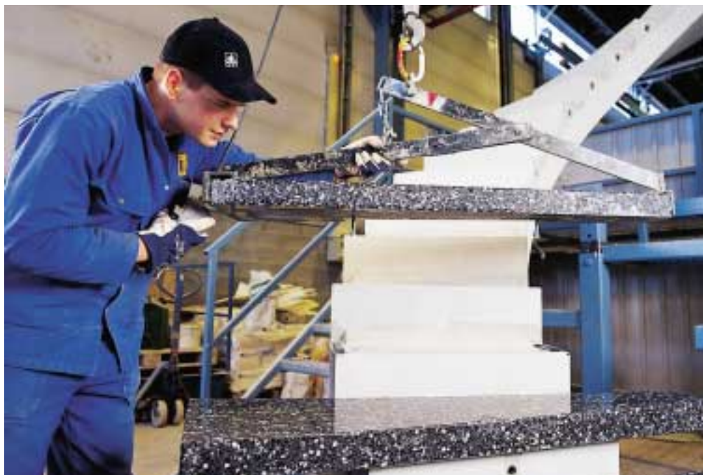
Lemminkäinen on valmistanut portaita yli 90 vuoden ajan. Ville Tuunanen kokoaa porruselementtiä.
