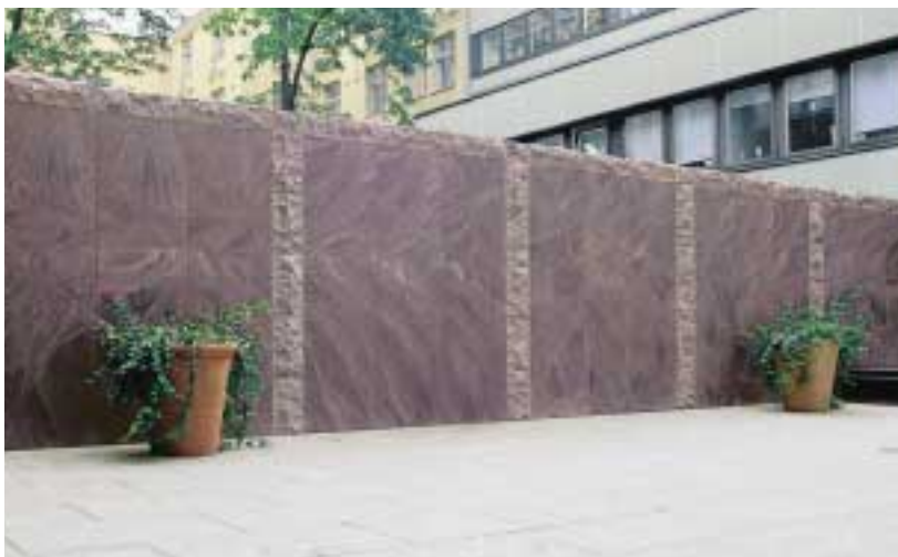
Helsingin islamilaiselle seurakunnalle rakennettu luonnonkivimuuri.
