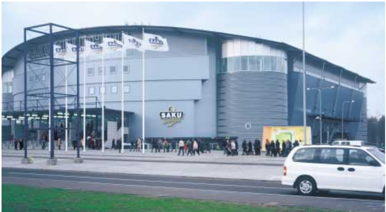
Monitoimihallien rakentaminen jatkui. Saku Suurhalli valmistui syksyllä Tallinnassa.
