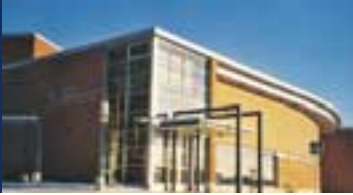
Oulun kaupungille peruskorjattiin ja laajennettiin Raksilan uimahalli.
