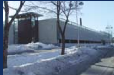
Tampereen Teknilliselle Korkeakoululle toteutettiin pysäköintilaitos, jonka suunnitelmia NCC jalosti niin, että autopaikkoja saatiin 390 paikasta 450.
