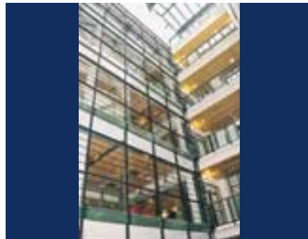
Työterveyslaitos oli mallikelpoisesti hoidettu työmaa, jonka rakennuttaja, Senaatti-kiinteistöt, valitsi Vuoden rakennushankkeeksi.
