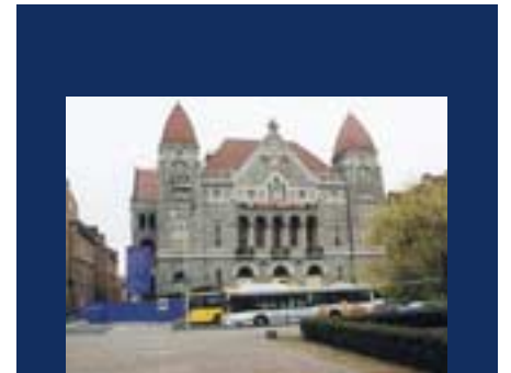
Kansallisteatteri Helsingin keskustassa on vaativa peruskorjauskohde.
