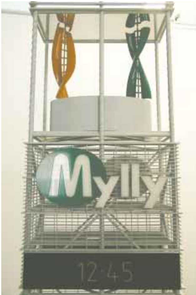
Kauppakeskus Myllyn 50 m korkean tornin huipulla pyörii kaksi turbiinia, joiden energiantuotto käytetään hyväksi kauppakeskuksen ravintolamaailmassa.
