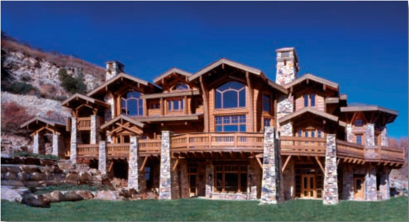
Vuoden suurin rakennuskohde oli amerikkalaisen jalkapalloilijan Steve Youngin talo, kaikkien aikojen toiseksi suurin Honka-hirsirakennus.
