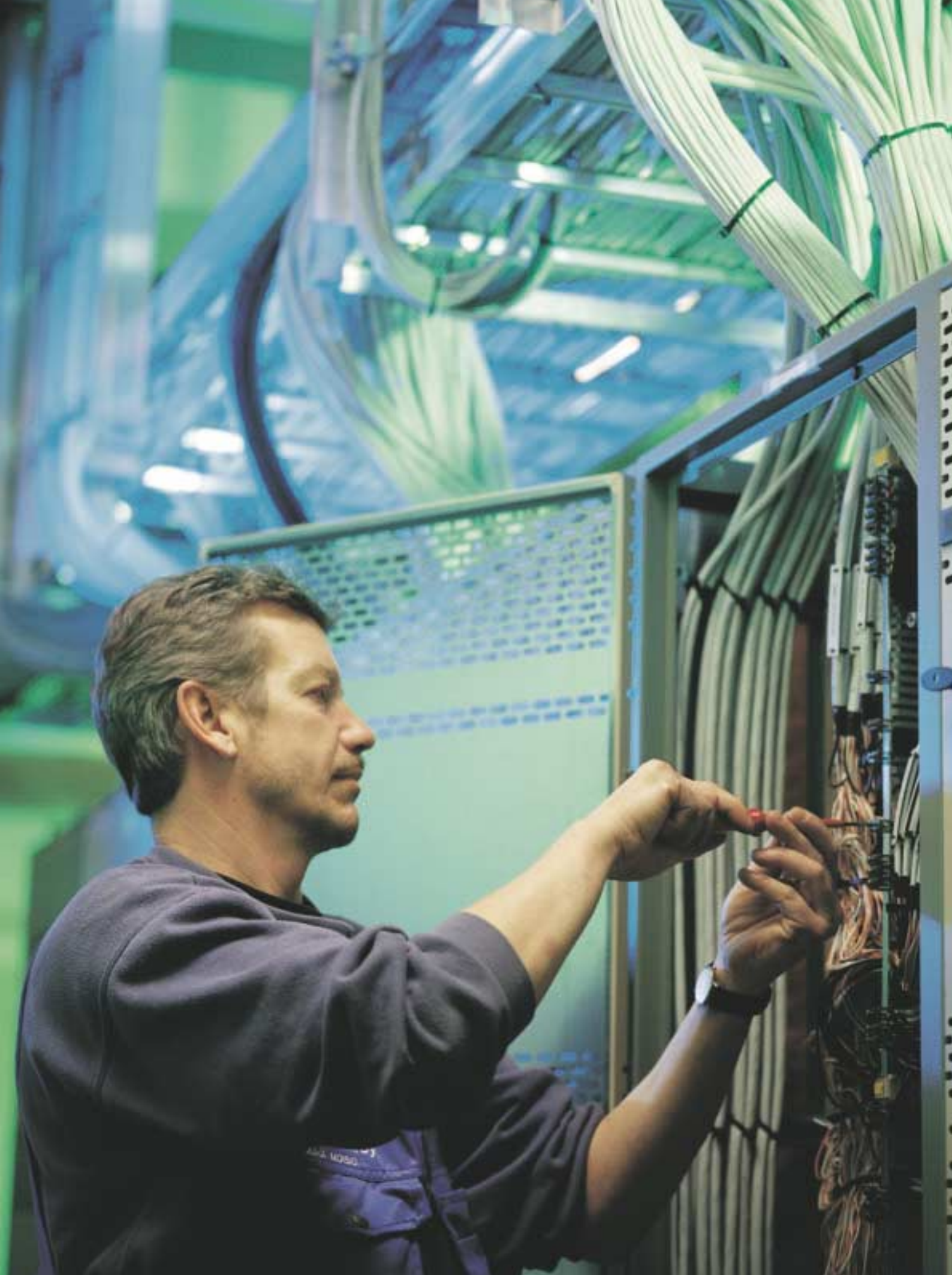
Asentaja Juha Moisio kytkee automaatiojärjestelmän kaapeleita Äänevoima Oy:n biovoimalaitoksessa Äänekoskella, jonne Tekmanni toimitti kattilalaitoksen prosessisähköistyksen.
