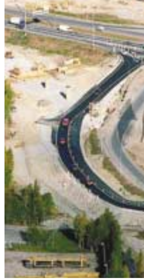
Kehä III:n vaativa tierakennusurakka käynnistyi Lentoasemantien ja Tikkurilan liittymän välillä.
