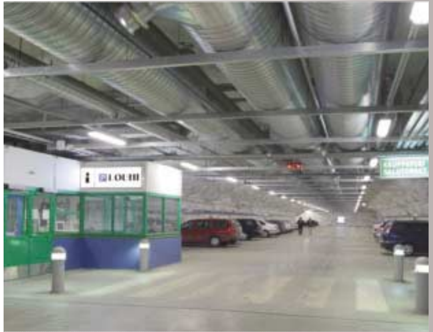
Tekmanni toteutti Turussa maanalaisen P-Louhi -pysäköintilaitoksen LVISA- ja sprinkleriasennukset.
