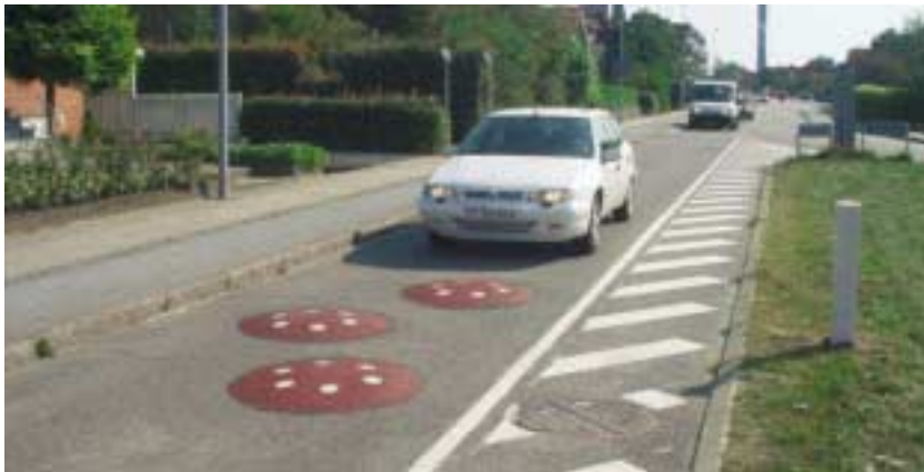
Lemminkäinen AS on kehittänyt Tanskassa taajamaliikennettä säätelevän ”Mushrooms”-hidasteen, joka sallii hyötyajoneuvojen esteettömän liikennöinnin. Tätä patentoitua tuotetta on kokeiltu myös muissa maissa.
