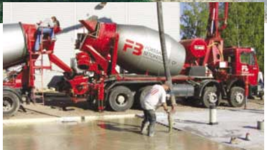
Forssan Betonituotteen tuotekehitys on kohdistunut mm. lattiabetoneihin. Varastohallin lattiaa valetaan Sipoon Talmassa.
