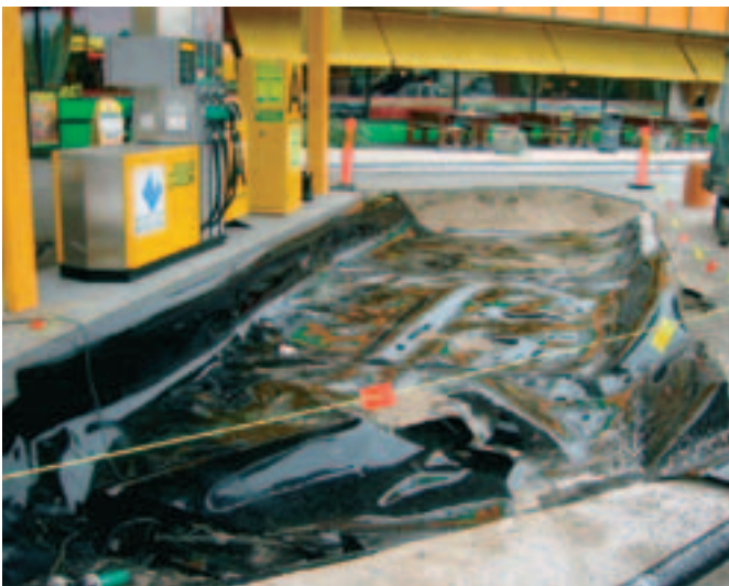
Riibimäellä ABC-liikennemyymälä Karavaanin mittarikentälle asennettiin lokakuussa muovikalvo suojaamaan maaperää ja pohjavesiä.
