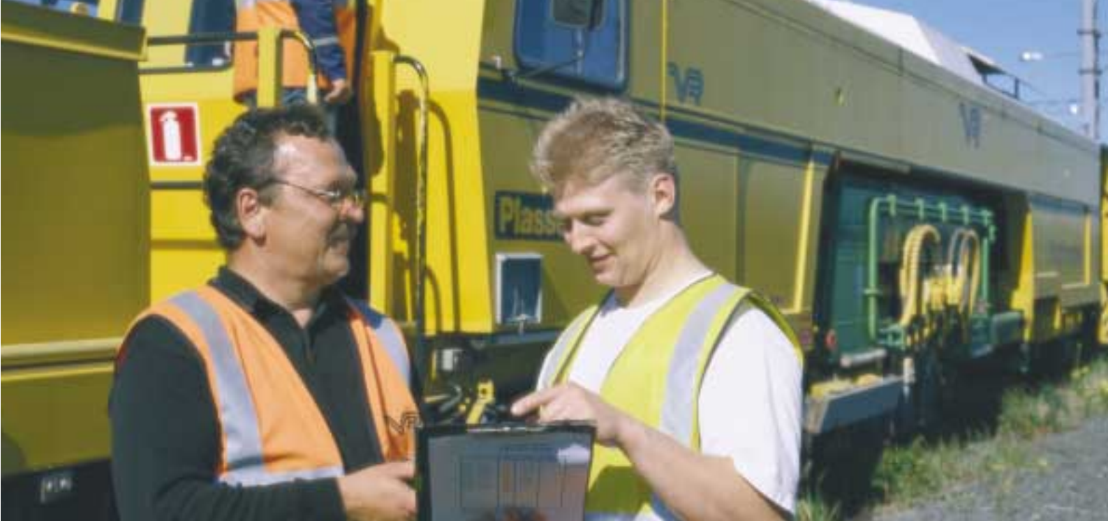
Ratatyökoneet ovat pitkälle automatisoituja, koska työssä vaaditaan tarkkuutta ja nopeutta. Kuvassa raiteentukemiskone ja sen miehistöön kuuluvat rataesimies Jukka Makkonen ja ratatyökoneen käyttäjä Jukka Latva.
