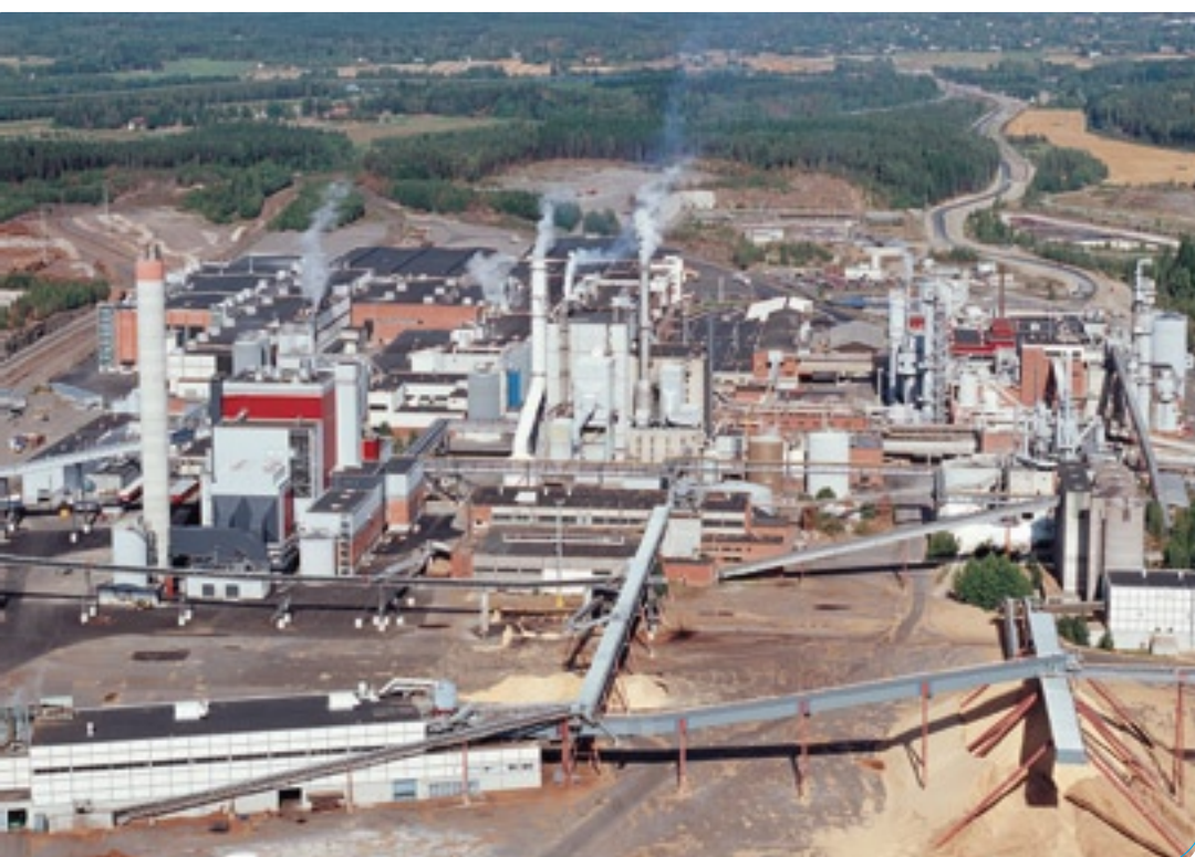
Kymin Voiman uutta biopolttoainevoimalaitosta on rakennettu YIT:n usean yksikön yhteisvoimin. Putkistoja, prosessilaitteistoja ja sprinklerilaitoksen saanut uusi voimala vihittiin käyttöön syksyllä 2002.
