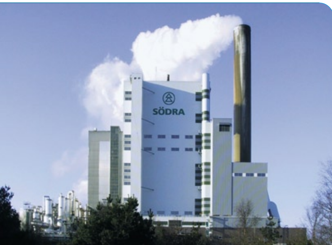
Södra Cell, Värön tehdas: Uuden soodakattilan prosessiputkistojen asennus sekä LVI-työt.
