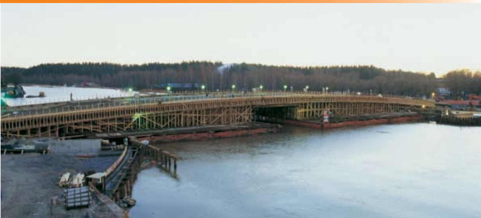
Porvoon Aleksanterinkadun silta ennen mittavia betonivaluja.
