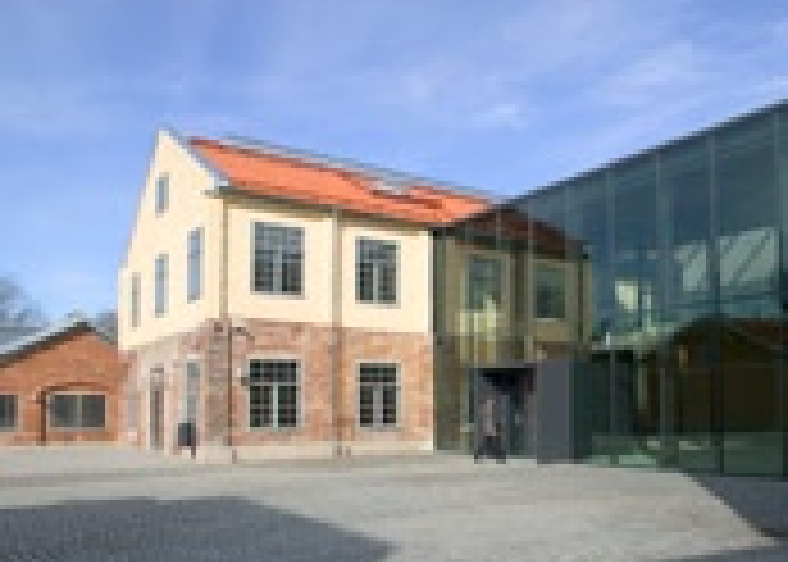
Åbo Akademin Arken-korttelin vanhimmat rakennukset ovat 1850-luvulta. Suojeltujen rakennusten peruskorjaus ja uuden tekniikan soveltaminen tiloihin on vaativaa työtä. Kuva: Voitto Niemelä
