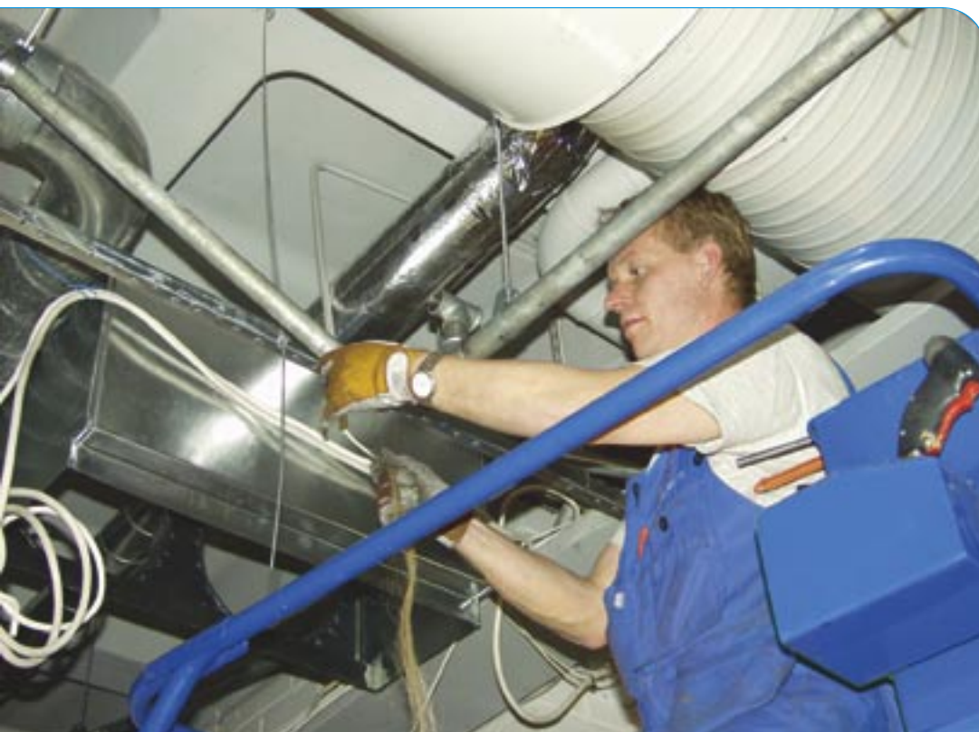
Sähköasentaja Reima Sintonen Hansa-korttelin työmaalla Turussa
