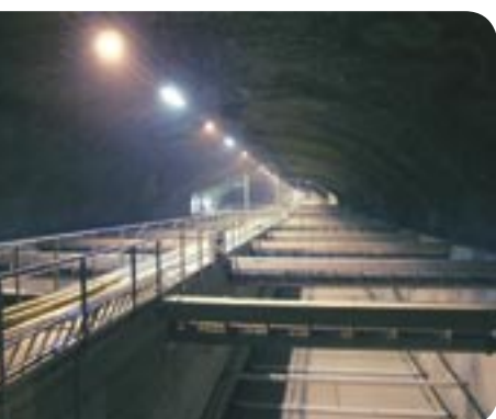
Helsingin Viikin jätevedenpuhdistamon sisustustyöt
