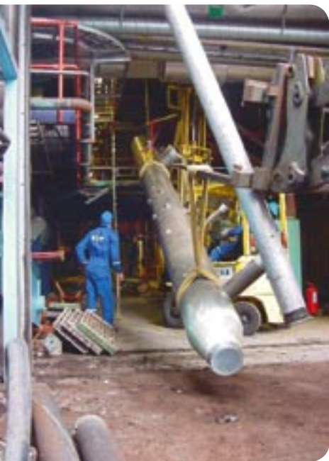
Höyryjakotukkia haalataan asennuspaikalle.
