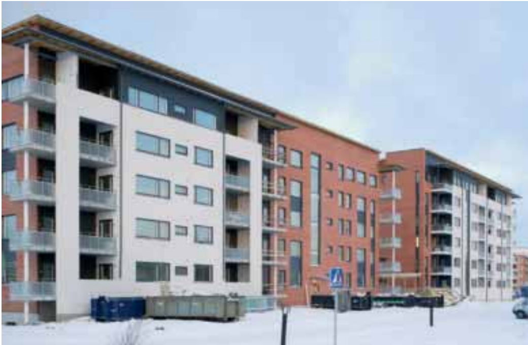
Palmberg-Rakennus Oy rakensi uusia asuntoja mm. YH:lle ja VVO:lle Oulun Aineen alueella.
