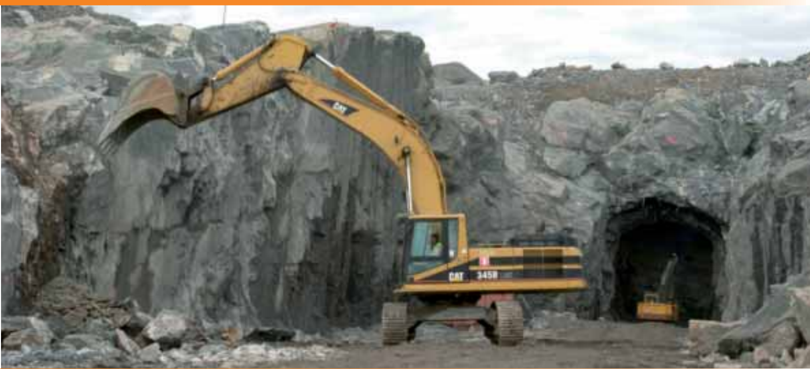
Lemcon rakentaa Olkiluodon ydinvoimalan tulo- ja menovesikanavat tunneleineen.
