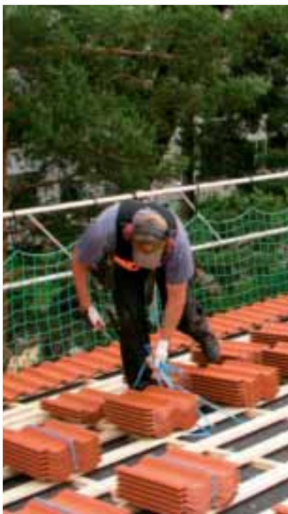
Asianmukaisesti asennetut turvakaiteet suojaavat sekä työntekijöitä että ulkopuolisia.
