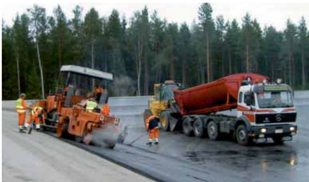
Lemminkäisen tuottamat tiiviit asfalttirakenteet soveltuvat hyvin maaperän ja pohjavesien suojaamiseen. Oulun Ruskon kaatopaikan pohjalle levitetään tiivistä asfalttia.
