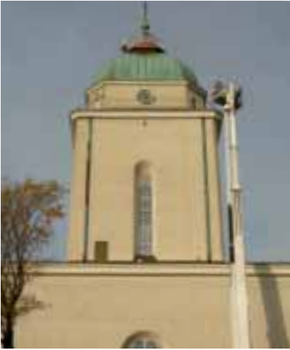
Matkapuhelinverkon tukiasemaa asennetaan Suomenlinnassa.
