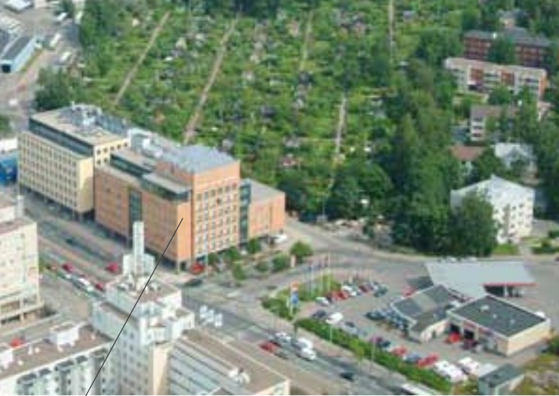
NCC-talojen rapatut julkisivut jatkavat Töölön perinteistä kaupunkikuvaa.
