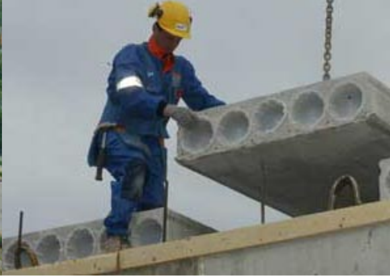
Työmaalla ollaan tarkkana. Työturvallisuusnäkökohdat heijastuvat myös työn jälkeen.
