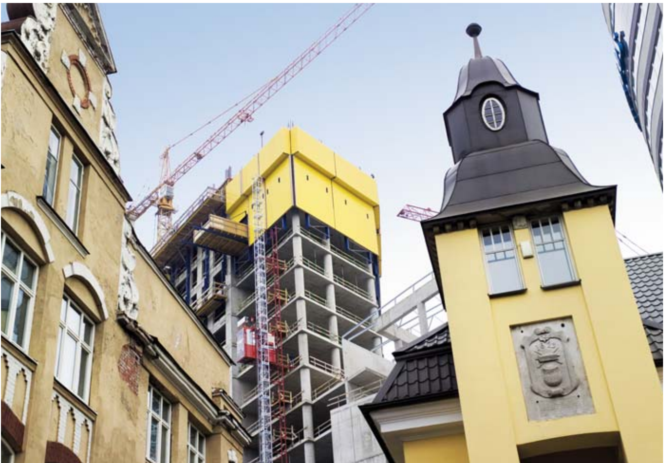
Tallinnan tornitalotyömaalla käytetään rakennuksen mukana nousevia seinäelementtejä, jotka suojaavat putoamisilta ja toimivat tuulensuojana.
