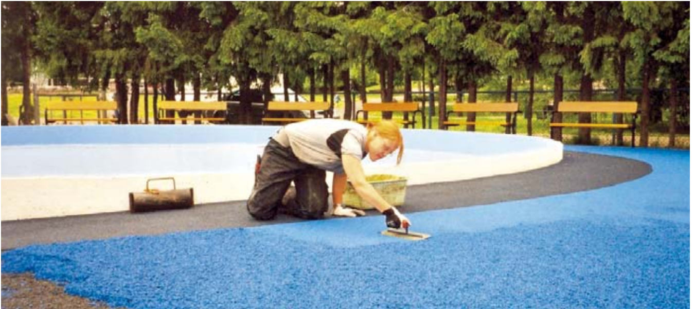
NovoKid-turvapäällystettä asennetaan Pukinmäen Unikkopuistossa Helsingissä.
