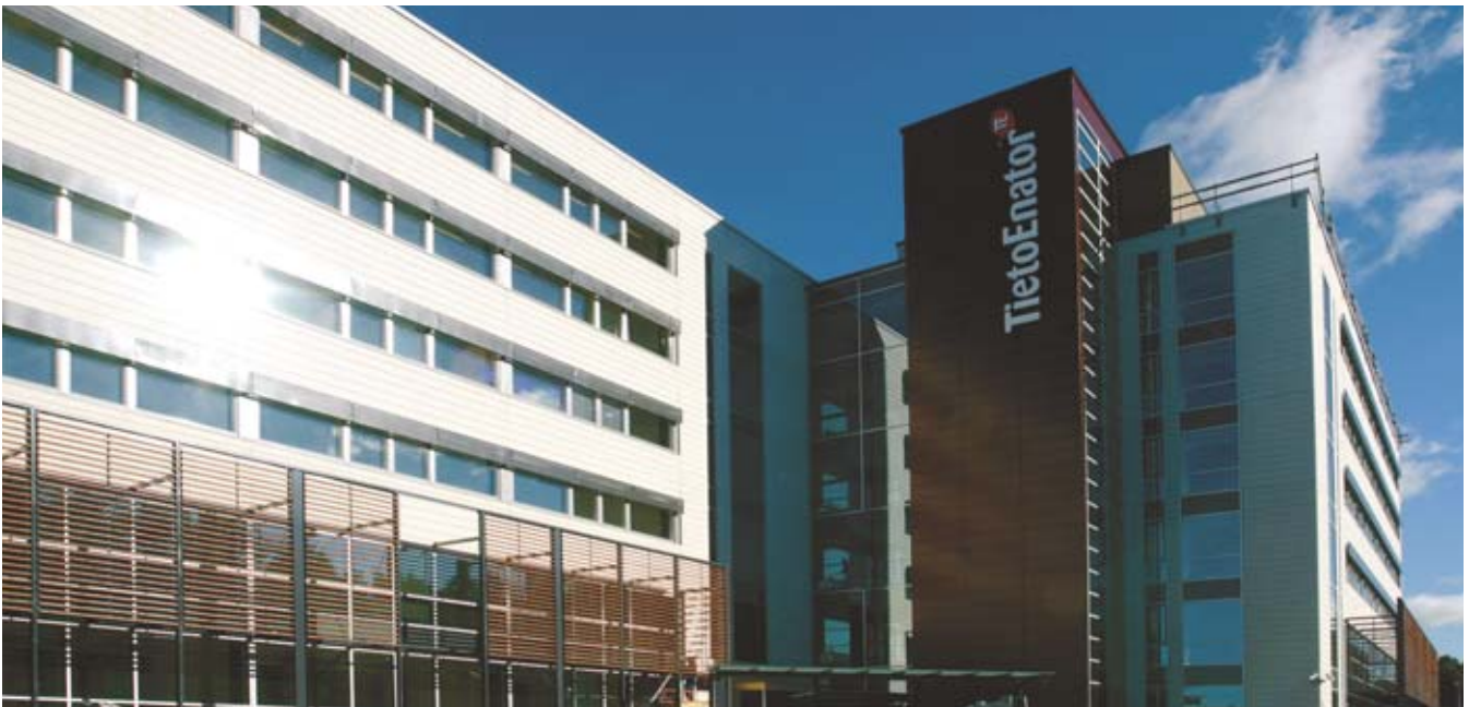
TietoEnatorin toimistotaloon asennettiin lähes 6 000 sprinkleriä.
