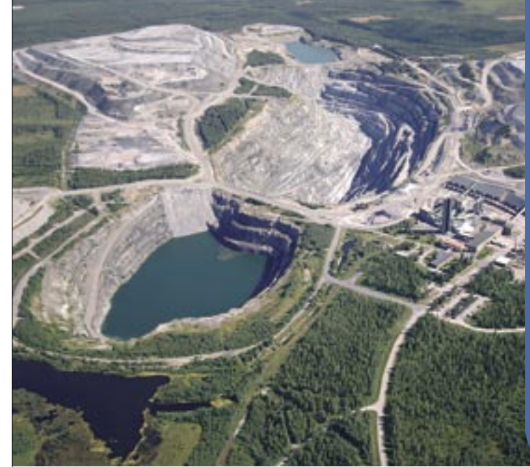
EU-maiden ainoalla kromikaivoksella Kemissä aloitettiin tunnelien louhinta Outokumpu Chrome Oy:lle.
