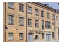
Property: Bulevardin Wiinanpolttimo Kiinteistö Oy Address: Hietalahdenranta 9, Helsinki Built: 1999
