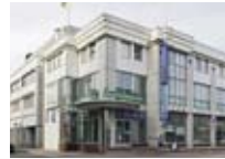
Property: Vantaan Sampotala Kiinteistö Oy Address: Peltolantie 1, Vantaa Built: 1987
