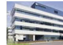
Kiinteistö: Espoon Keilaranta 5 Kiinteistö Oy Osoite: Keilaranta 5, Espoo Rakennettu: 2001
