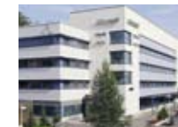
Kiinteistö: Espoon Keilaranta 7 Kiinteistö Oy Osoite: Keilaranta 7, Espoo Rakennettu: 2001
