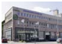
Kiinteistö: Henry Fordinkatu 6 Osoite: Henry Fordinkatu 6, Helsinki Rakennettu: 1946 Riski/tuottosuhte: Opportunistic
