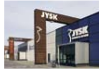
Kiinteistö: Pakkalanrinne Kiinteistö Oy Osoite: Antaksentie 4, Vantaa Rakennettu: 2002
