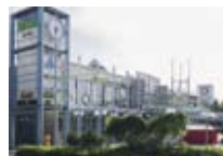
Kiinteistö: Niittykumpu 4 Kiinteistö Oy Osoite: Niittykumpu 4, Espoo Rakennettu: 1992
