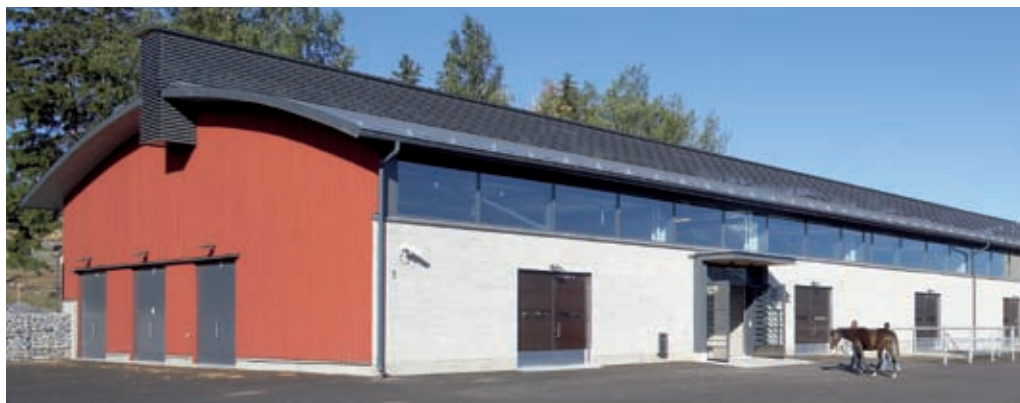
Helsingin yliopiston Eläin-sairaala valmistui keväällä 2006. Viikissä sijaitsevassa rakennuksessa on vaativia erikoistiloja, pintamateriaaleja, varusteluja ja talotekniikkaratkaisuja.
