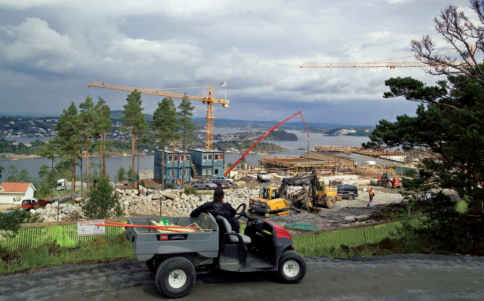
Onninen toimittaa materiaalit SPA ja Golf-hotellin työmaalle Kragerøssa, Norjassa.
