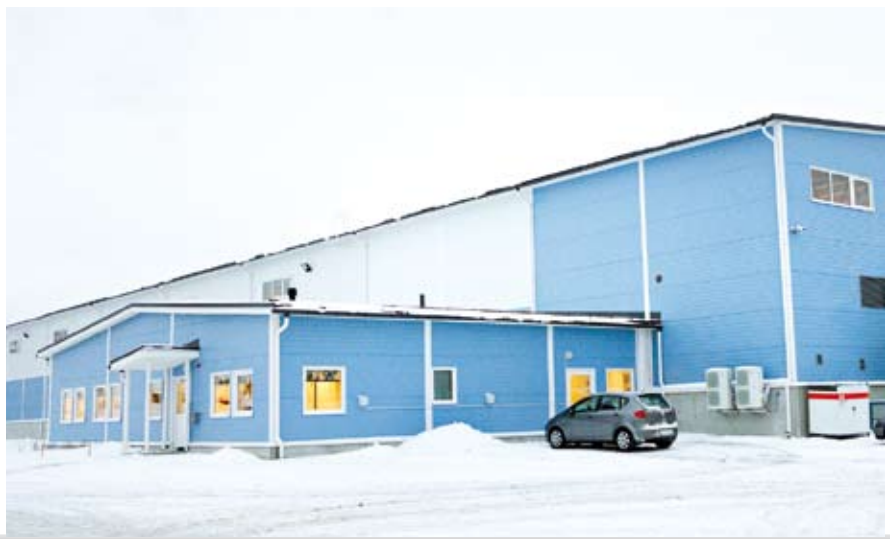
HT Lasertekniikka Oy's facilities in Vieremä.
