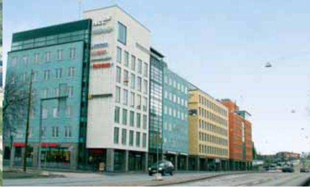
NCC-talo 3, Helsinki KUVA: NCC VIESTINTÄ
