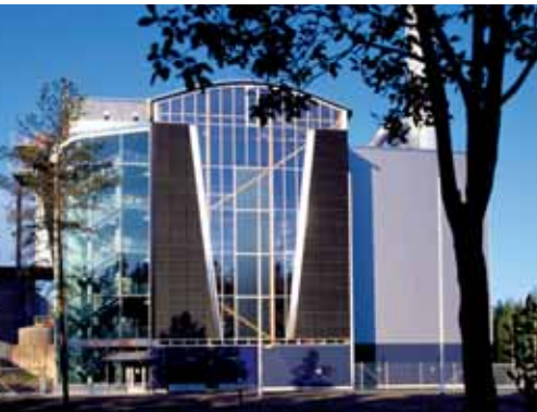
Orihedon biolämpökeskus tuotti hiilidioksidivapaasti lähes 16 % Turun kaukolämmöstä vuonna 2007.
