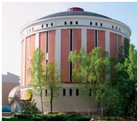
Historialliseen kaasukellorakennukseen sijoitettu kaukolämpöakku korvaa öljyn käyttöä. Lämpöakkuun varastoidaan lämpöä kulutushuippujen tasaamiseksi, jolloin pienempiä öljylämpökeskuksia ei tarvitse lyhyen kulutuspiikin johdosta käynnistää lainkaan.
