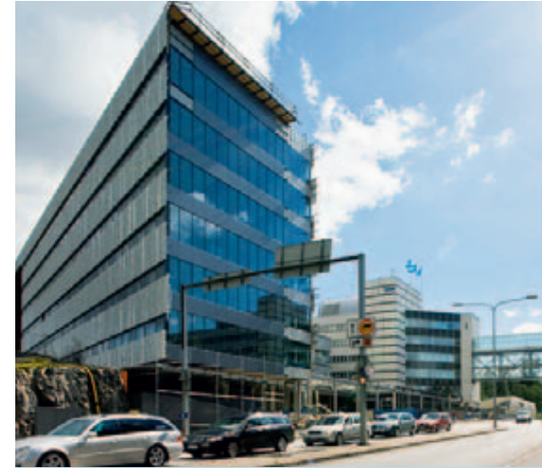
YIT:n pääkonttorin laajennus valmistui Helsingissä joulukuussa 2008.
